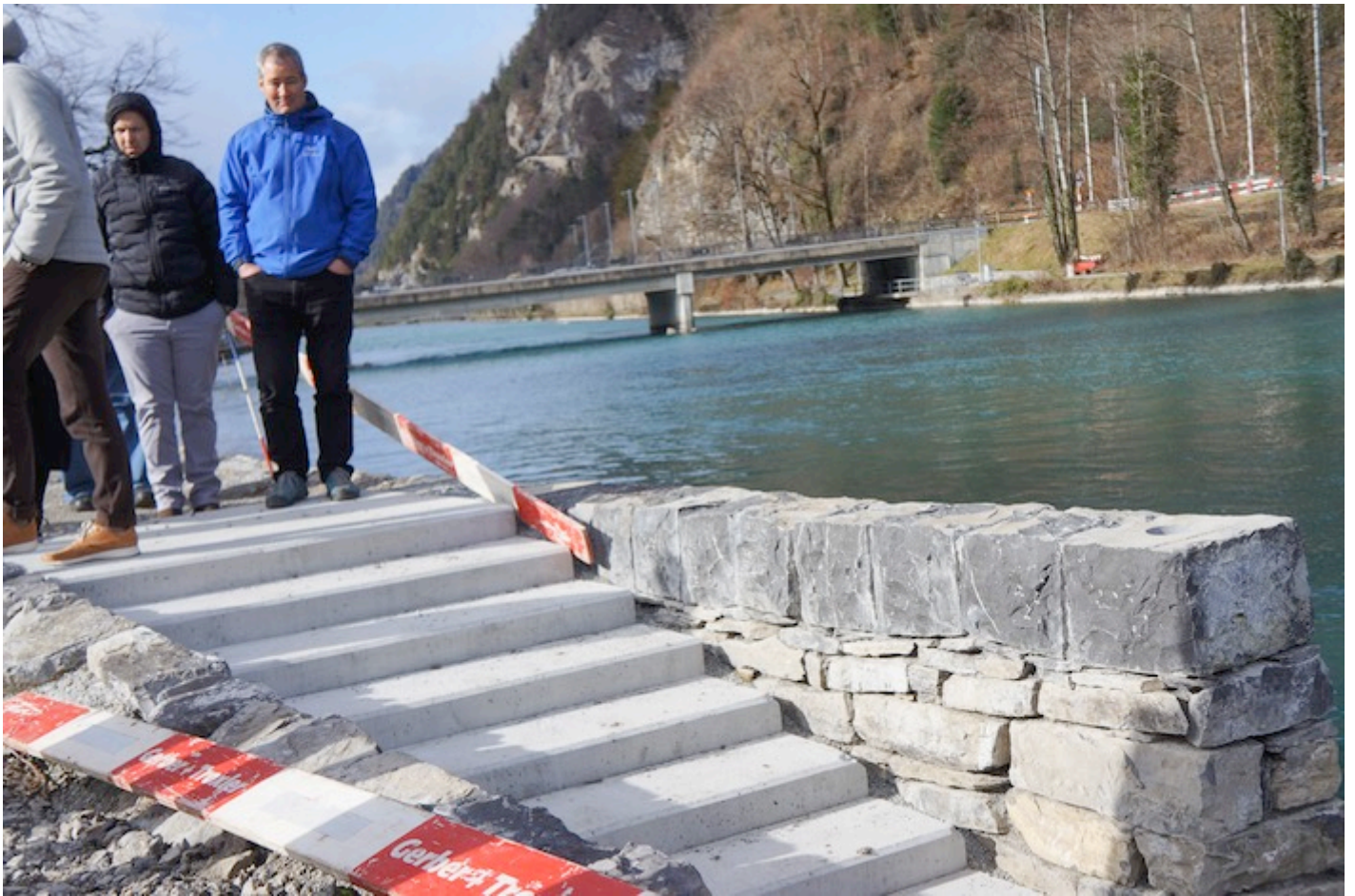
Bei der neu eingerichteten Plattform über der Aare wurde die historische Steinmauer erhalten und restauriert.
