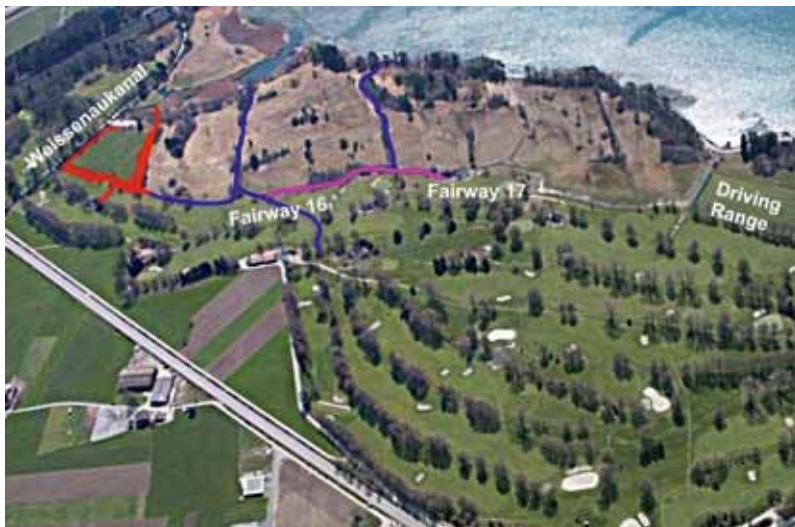
Abb. 1: Überblick Golfplatz – Naturschutzgebiet (Blickrichtung Südwest) mit den Bauetappen (ohne ökologische Aufwertung des Golfplatzes). Der Golfplatz ist noch im alten Zustand. Bauprojekt Werkhofgräben, Violett: Projekt Fairway-Aufwertung, Rot: Bauprojekt Bermudawiese.
