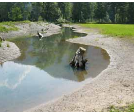
Abb. 16 (links): Die neu erstellte Querverbindung von der Spange Bermudawiese zum Weissenaukanal. Sie führt das ganze Jahr Wasser. Links ist der Erdwall gegen den Golfplatz; rechts das abgeflachte Ufer gegen die Wiese zu erkennen. Foto A. Bossert, Juni 2010
