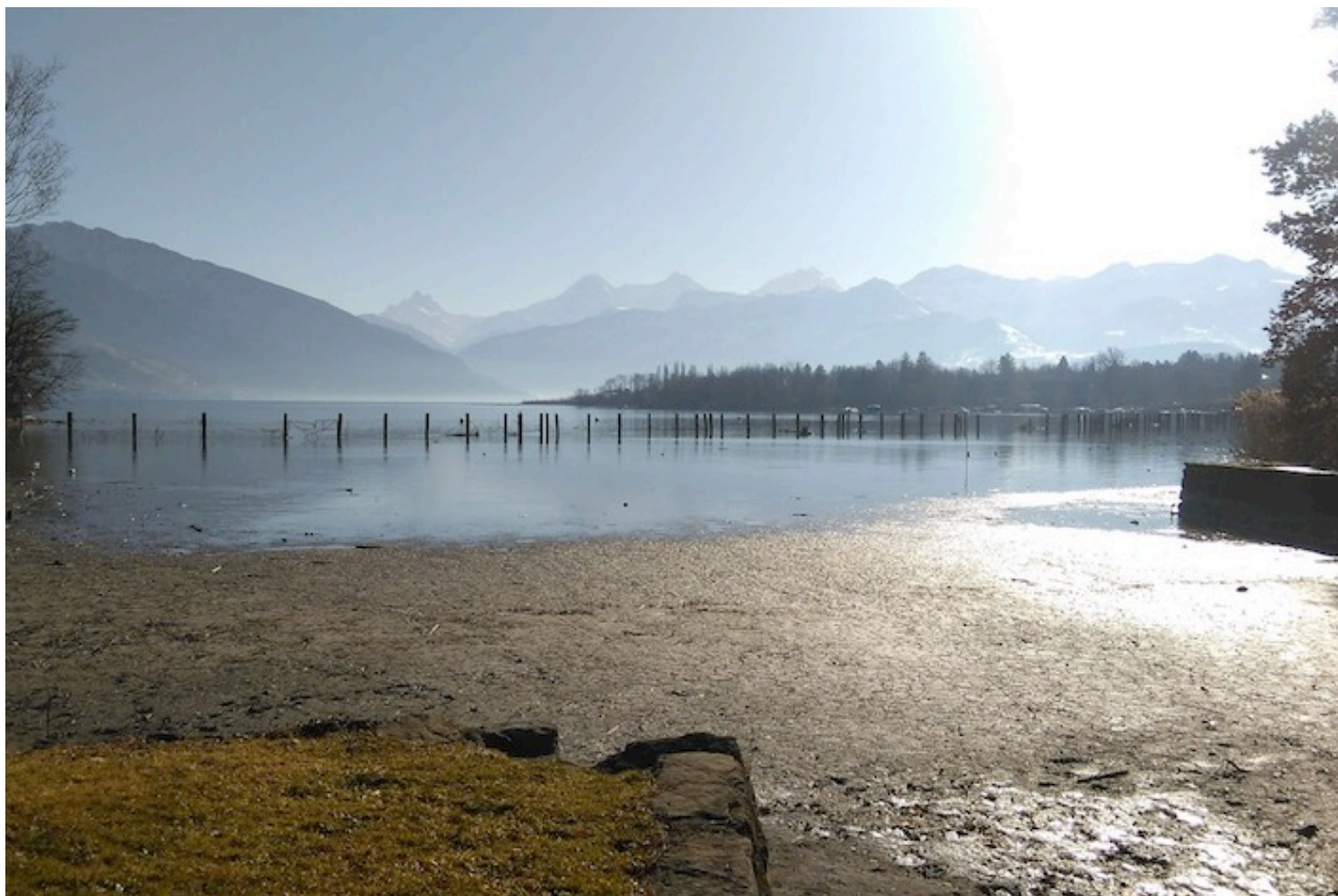
Im Gwattlischenmoos entsteht ein Schilfschutzzaun.
