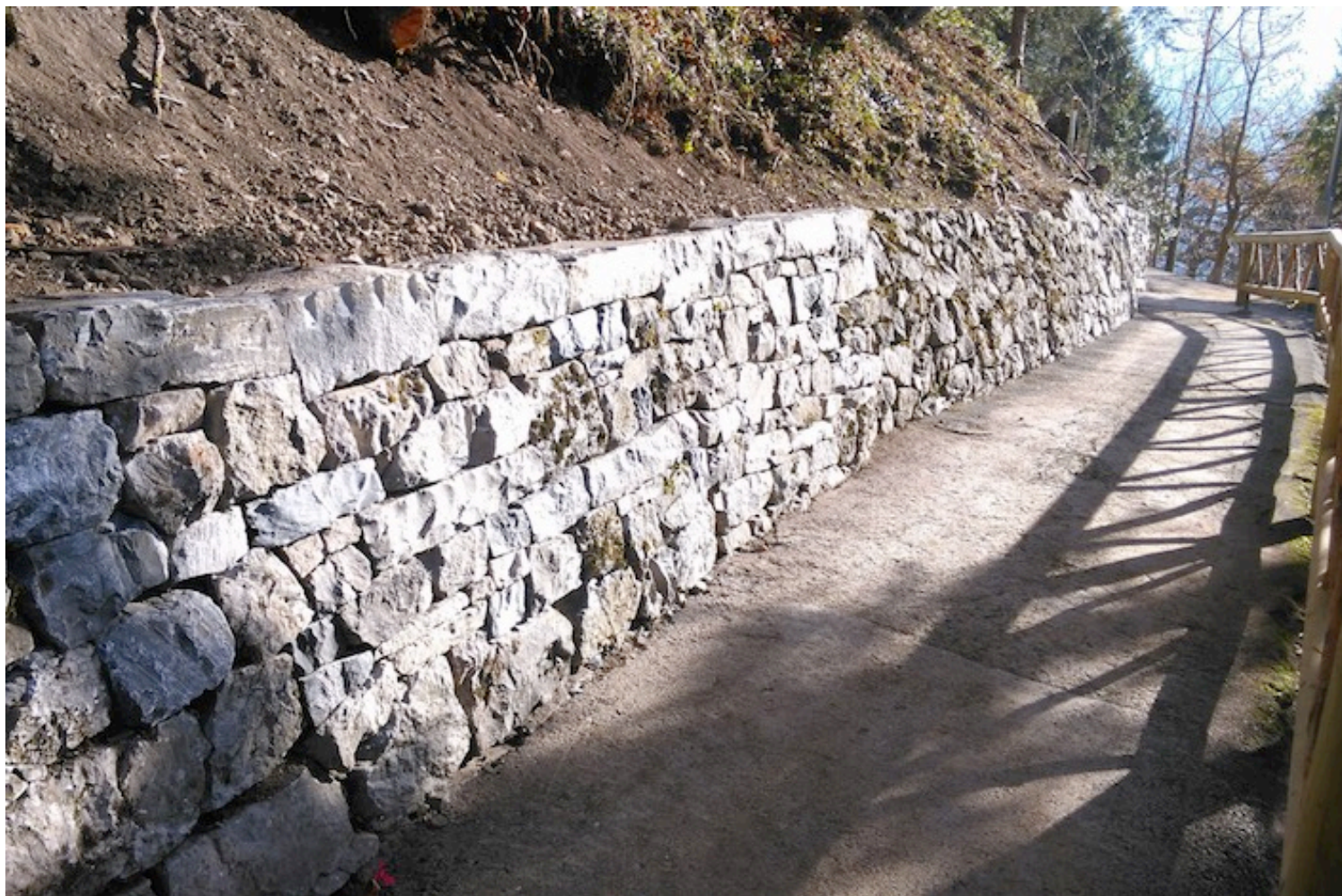
Am Pilgerweg bei den Beatushöhlen wurden vier Mauerabschnitte neu aufgebaut.
