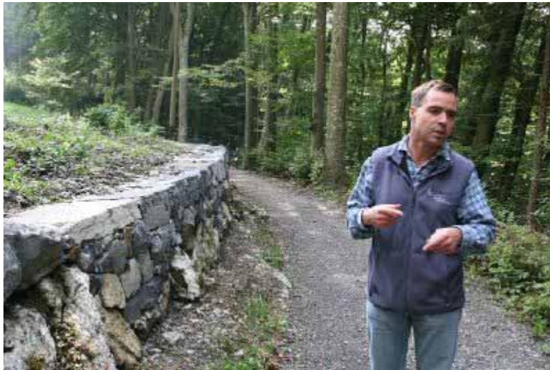
Revierförster Anton Wyss vom Forstbetrieb Sigriswil zeigt die Naturmauern. Diese wurden von freiwilligen Helfern erneuert.
