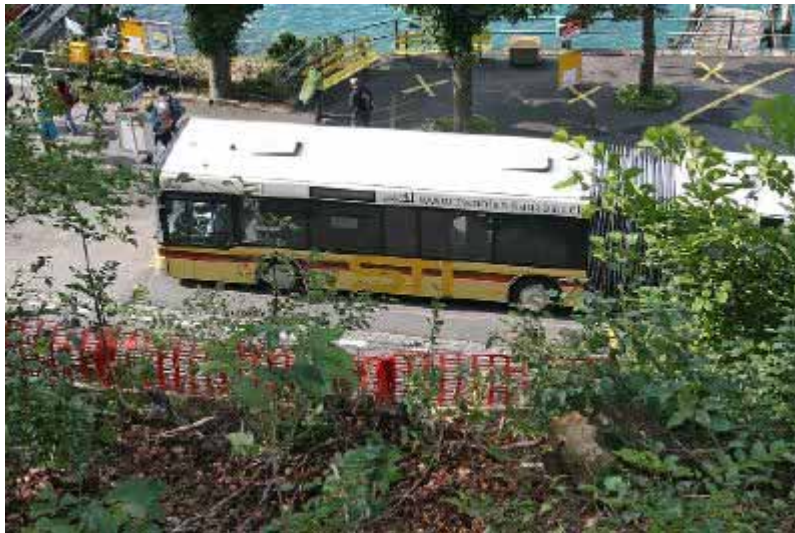
Schutzzäune sollen verhindern, dass Steine auf die Staatsstrasse herunterfallen.
